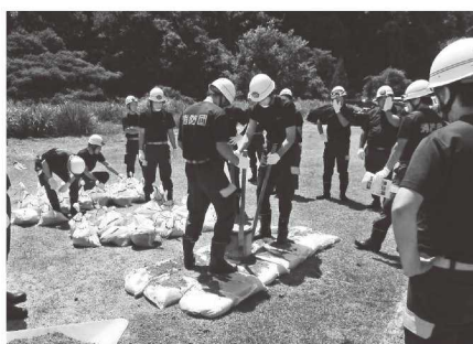
月の輪工法・釜段工作を学びます
