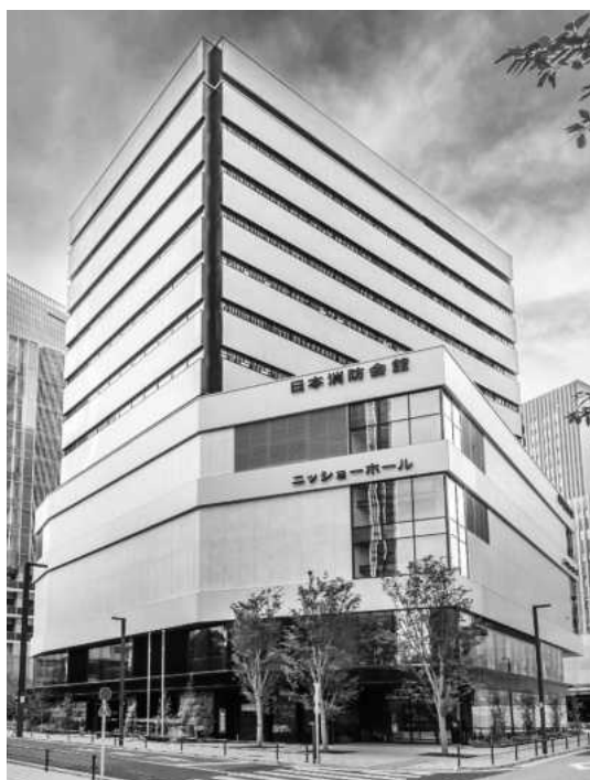
日本消防会館全景
