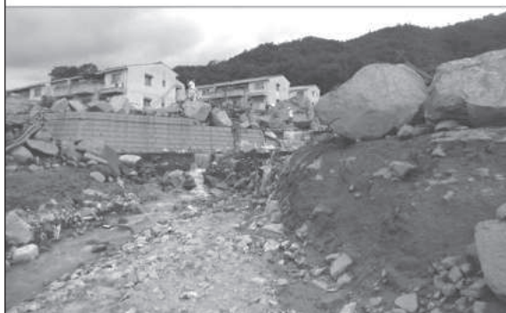
巨石で多くの家屋が倒壊した状況
